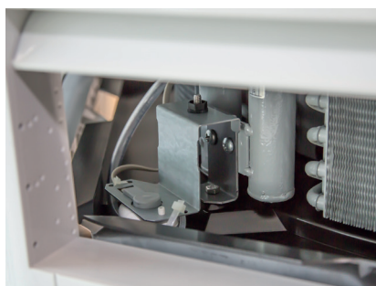
Interruttore a galleggiante montato nella lamiera di supporto
