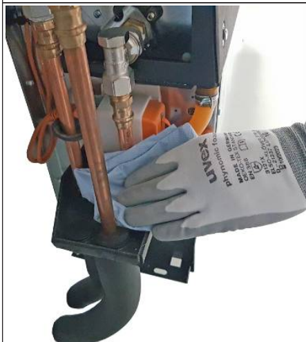
Fig. 74: Vaschetta per condensa valvole, esecuzione a parete
