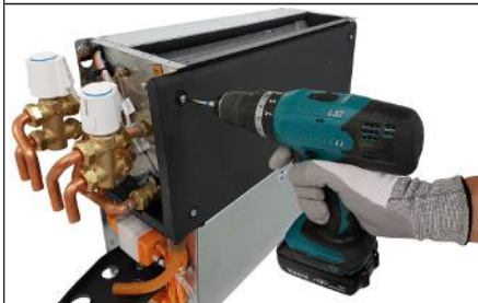
Fig. 71: Smontaggio della vaschetta principale della condensa (esecuzione a parete)
