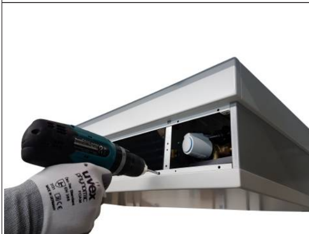
Fig. 9: Fissaggio del mantello con le viti
