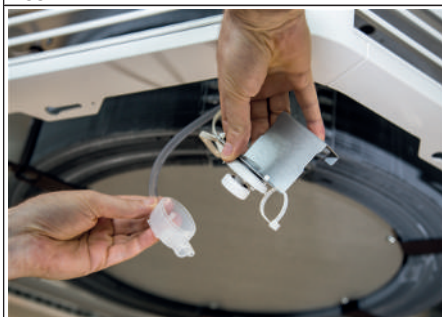
Fig. 37: Rimozione coperchio
